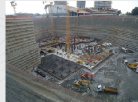
Temel Kotuna İnilmesi
